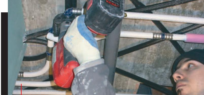
**1** Контролируйте правильность выполнения обжима благодаря светодиодной индикации в конце цикла.
